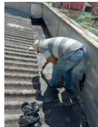
LIMPEZA E MANUTENÇÃO NAS CALHAS DO TELHADO DA
