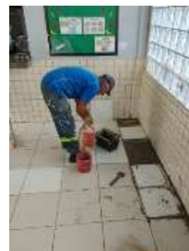
TROCA DE AZULEJOS NO REFEITÓRIO PISO/PAREDE
