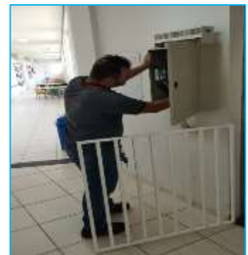
MANUTENÇÃO PREVENTIVA DO ELEVADOR
