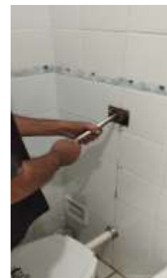
TROCA DA VÁLVULA DO REGISTRO DO BANHEIRO DA DIRETORIA
