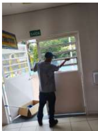
SERVIÇO DE VITRAÇARIA, TROCA DE 5 VIDROS QUEBRADOS NA MATERNAL
