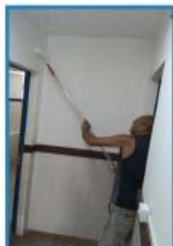
Pintura das paredes
