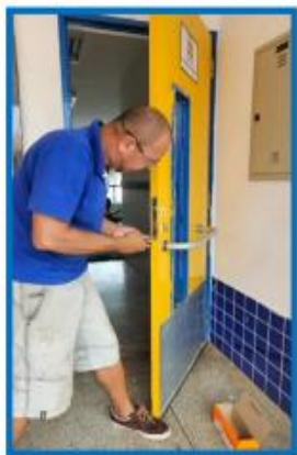
Trocas de maçanetas
